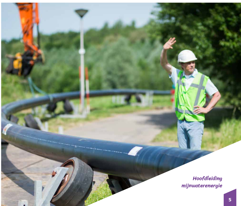
Voorbeeld 'uitwisselstation' in aanleg Terhoevenweg Hoensbroek
